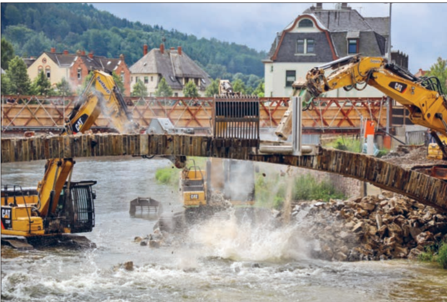
Am 02.08.2021 wurde die Bestandsbrücke über die Zschopau in Flöha-Plaue abgerissen. Foto: Stadtverwaltung Flöha/Erik Frank Hoffmann
