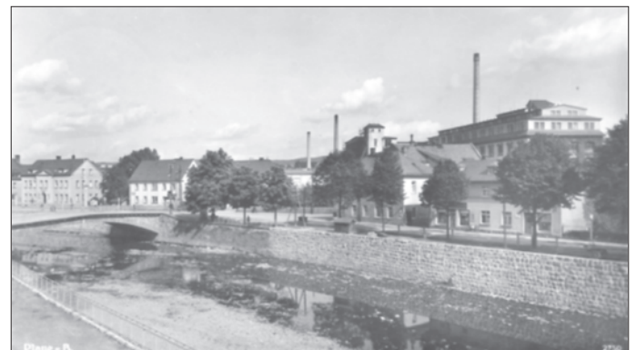
Bild 42: Aufnahme zur Zeit der Aufstockungsarbeiten am Lagergebäude vorn
